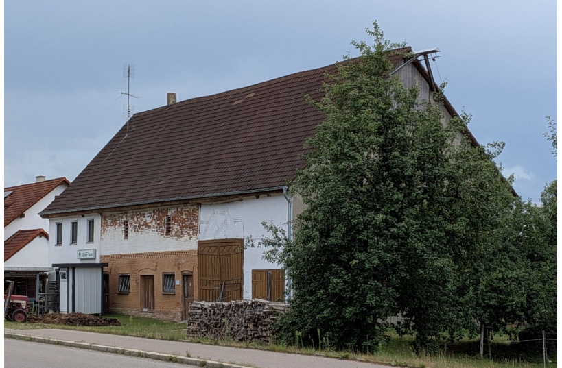
Niedernzell Haus Nr. 5 (erbaut 1888) an der Straße zwischen Gutenzell und Schwendi
